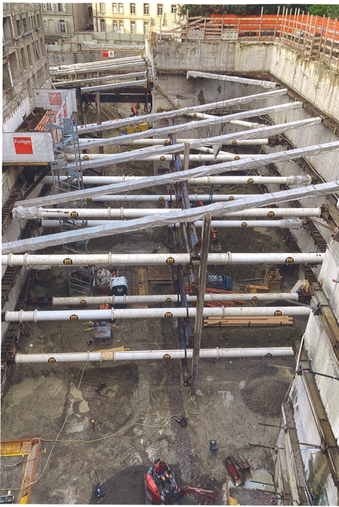
Étayage de la fouille de la partie nord
