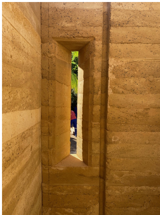
Figura 12– Detalhe seteira do banheiro e sulco para passagem de tubulação hidráulica
