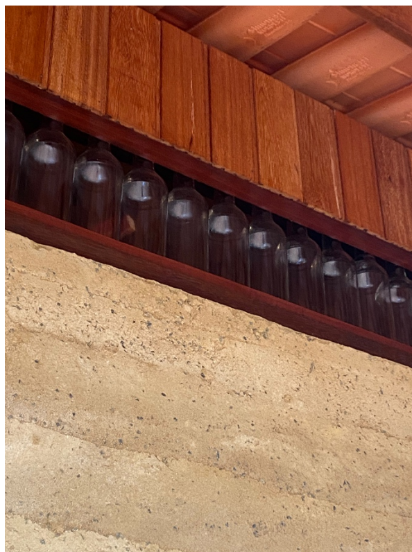
Figura 9 – garrafas trazem iluminação natural aos banheiros
