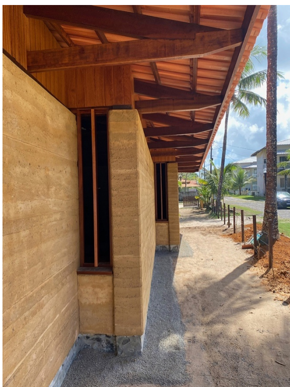
Figura 13– Fachada lateral quartos
