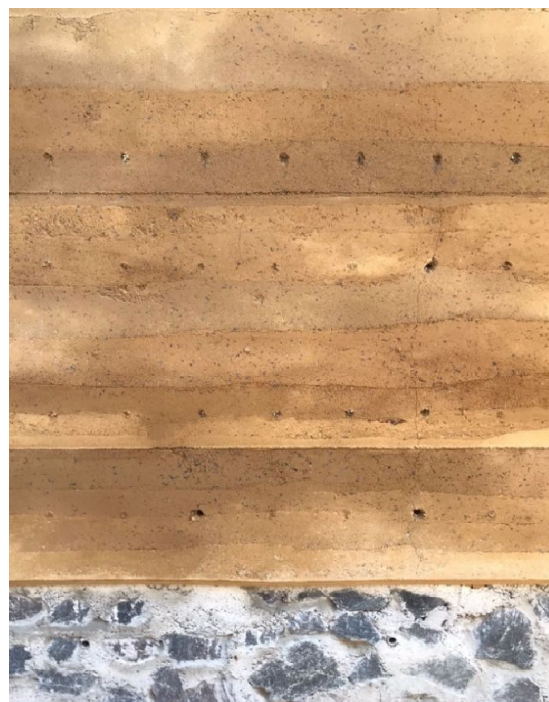
Figura 3. Detalhe base da parede concreto ciclópico
